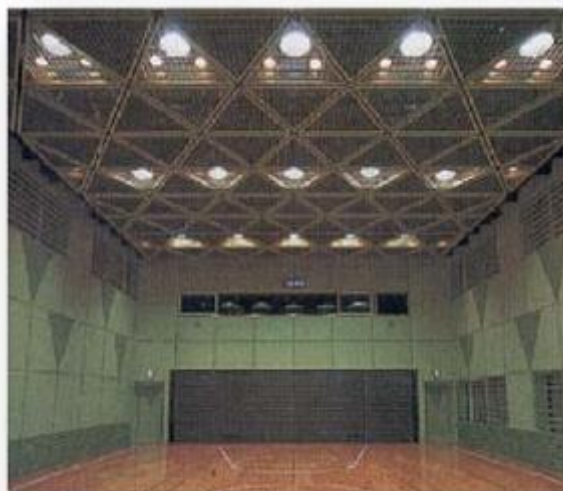
ภาพที่ 9.50 การติดตั้งโคมไฟในตำแหน่งที่ไม่ให้เกิดแสงแยงตา
