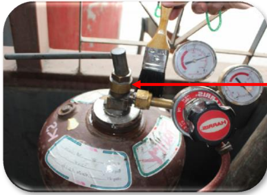
การตรวจสอบรอยรั่วแก๊ส
