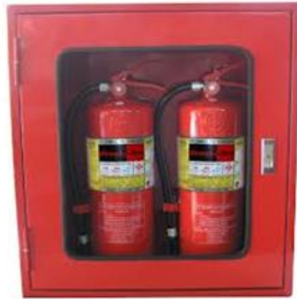
รูปที่ 1.10 แสดงลักษณะกล่องติดตั้งอุปกรณ์ดับเพลิง ที่มา : นายชำนาญ ช่วยคุณูปการ , 2562
