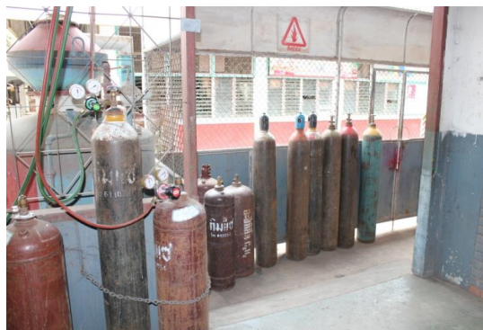
รูปที่ 1.7 แสดงลักษณะห้องเก็บแก๊สอะเซทิลีน
