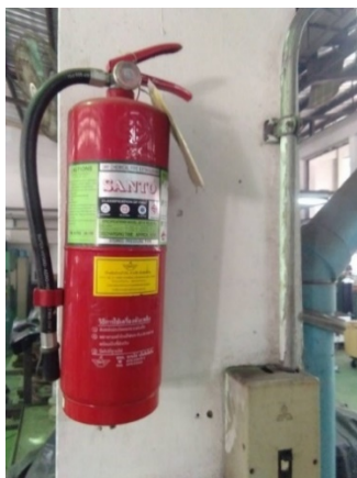
รูปที่ 2.15 แสดงการเตรียมอุปกรณ์ดับเพลิงให้พร้อมใช้อยู่เสมอ
