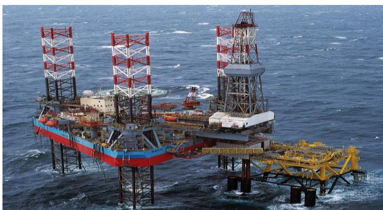
ภาพที่ 1.14 แสดงแท่นขุดเจาะแบบยกขาตั้ง (ที่มา : http://www.geothai.net/petroleum-drilling1/ )
